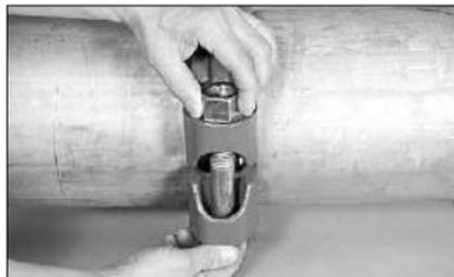
3. **INSTALLATION DES BOULONS ET ÉCROUS :** insérez les boulons dans les patins puis vissez un écrou sur chaque boulon et serrez-les à la main. **REMARQUE :** veillez à ce que le collet ovale de chaque boulon soit bien en place dans le trou de boulon.
