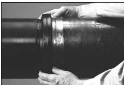
**4. ASSEMBLAGE DES EXTRÉMITÉS DE TUBES** : alignez les tubes NPS et JIS face à face et rapprochez leurs extrémités. Glissez le joint en position et centrez-le entre les rainures de chacune des extrémités des tubes.
