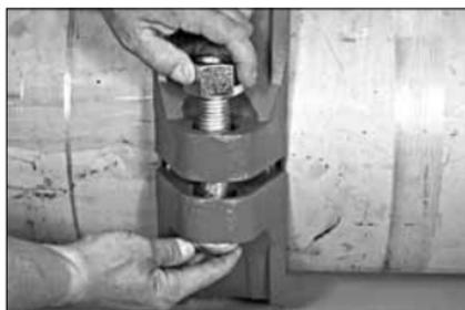
**4. JONCTION DES EXTRÉMITÉS DE TUBES :** alignez et réunissez les deux extrémités des tubes. Mettez en place le joint d'étanchéité en le faisant glisser et centrez-le dans la rainure de chaque extrémité des tubes ou du Vic-Ring AGS.
