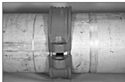
**6. MONTAGE DES SEGMENTS :** placez les segments sur le joint. Assurez-vous que les talons des segments s'engagent complètement dans la rainure de chaque extrémité de tube ou de Vic-Ring AGS. Soutenez les segments tout en préparant le montage des boulons et écrous.
