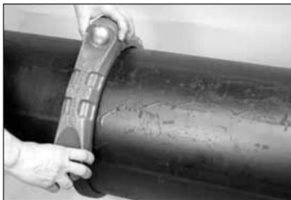
3. **MISE EN PLACE DU PREMIER ENSEMBLE DE SEGMENT** : mettez un des segments pré assemblés en place sur le joint. Vérifiez que les talons des segments s'engagent complètement dans les rainures des extrémités des deux tubes.
