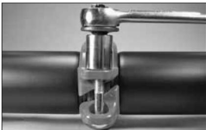
**6. SERRAGE DES ÉCROUS :** serrez les écrous de manière régulière en alternant les côtés jusqu'à ce que les surfaces métalliques des patins obliques soient en contact. Veillez à ce que les talons des segments s'engagent complètement dans les rainures et à ce que les décalages soient égaux au niveau des patins. Pour garantir la rigidité du raccord, des décalages égaux et positifs sont préférables.
