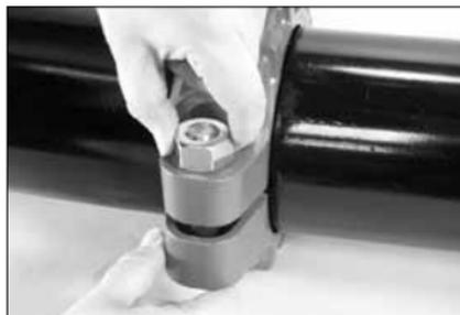
3. **INSTALLATION DES BOULONS ET ÉCROUS :** insérez les boulons puis vissez un écrou sur chaque boulon et serrez-les à la main. Pour les colliers équipés d'un matériel en acier inoxydable, appliquez un anti-grippant sur les filets des boulons. **REMARQUE :** veillez à ce que le collet ovale de chaque boulon soit bien en place dans le trou de boulon.
