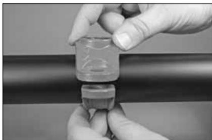
**3. MISE EN PLACE DU SEGMENT :** mettez le segment de piquage en place sur le tube en centrant la collerette de positionnement dans le trou. Vérifiez que le segment de sortie soit bien engagé en essayant de le faire aller et venir tout en appuyant dessus. S'il est correctement en place, il doit pouvoir bouger un peu, dans n'importe quelle direction.
