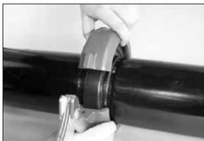
**2. MISE EN PLACE DES SEGMENTS :** placez une moitié du segment articulé au-dessus du joint, en vous assurant que les talons s'engagent dans les rainures. Faites pivoter l'autre moitié du segment en position. Pressez le segment pour finir de centrer le joint et de mettre le segment en place.
