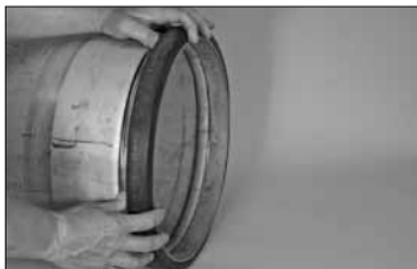
3. **MISE EN PLACE DU JOINT** : mettez le joint en place sur l'extrémité du tube ou sur le Vic-Ring AGS. Assurez-vous qu'il ne dépasse pas de l'extrémité du tube ou du Vic-Ring AGS.
