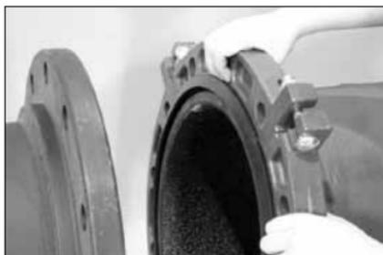
**6. ALIGNEMENT DE LA BRIDE VIC-FLANGE ET DE LA CONTRE-BRIDE :** faites tourner la bride Vic-Flange sur l'extrémité du tube si nécessaire pour aligner les trous à la contre-bride.
