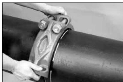
**7. MISE EN PLACE DU PREMIER ENSEMBLE DE SEGMENTS :** mettez en place des moitiés pré assemblées en place sur le joint.
