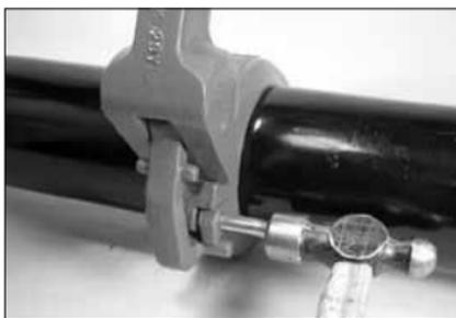
**6. MISE EN PLACE DE LA GOUPILLE :** utilisez un marteau pour enfoncer la goupille dans les trous des segments du collier alignés jusqu'à ce que la zone cannelée se trouve dans le trou.
