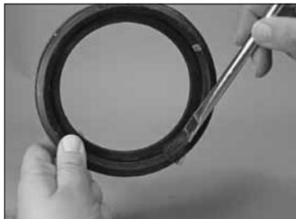
3. **LUBRIFICATION DU JOINT** : appliquez une mince couche de lubrifiant Victaulic ou de lubrifiant silicone sur les lèvres d'étanchéité du joint à l'intérieur et sur l'extérieur. Il est normal que la surface du joint ait une couleur blanchâtre après qu'il ait été utilisé.
