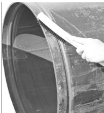
1b. Nettoyez la surface extérieure du tube, depuis la rainure jusqu'à l'extrémité du tube, afin de retirer toute trace d'huile, de graisse, de peinture écaillée et de saleté.
