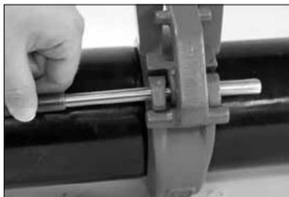
**1.** Engagez la barre en T de l'outil de montage Style 792 dans les creux usinés (pas le côté « moulé ») du côté de l'axe le plus long. Engagez le bec de l'outil dans le creux central. Abaissez le manche jusqu'à ce que l'outil heurte le segment. Maintenez l'outil dans cette position.
