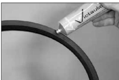
**4. CONTRÔLE ET LUBRIFICATION DU JOINT :** vérifiez que le joint convient pour l'utilisation envisagée. Le code couleur indique la nature du joint. Appliquez une mince couche de lubrifiant Victaulic ou de lubrifiant au silicone sur les lèvres intérieures et à l'extérieur du joint.
