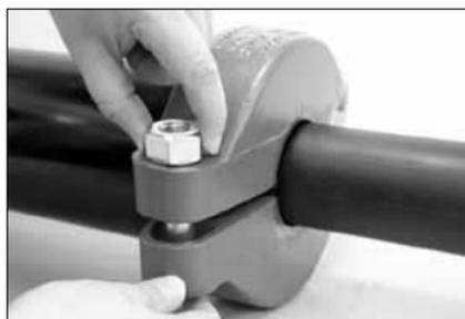
**6. INSTALLATION DES BOULONS ET ÉCROUS :** insérez les boulons dans les patins puis vissez un écrou sur chaque boulon et serrez-le à la main. **REMARQUE :** veillez à ce que le collet ovale de chaque boulon soit bien en place dans le trou de boulon.
