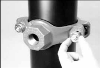
**4. INSTALLATION DU BOULON ET DE L'ÉCROU RESTANTS :** insérez le boulon restant. Serrez un écrou sur le boulon à la main. **REMARQUE :** veillez à ce que le collet ovale de chaque boulon soit bien en place dans le trou du patin.
