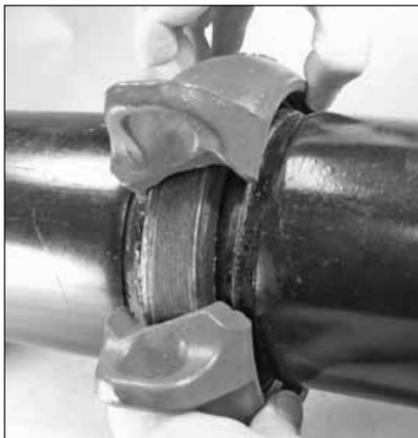
7. **MONTAGE DES SEGMENTS DE COLLIER** : mettez les segments de collier en place sur le joint. Vérifiez que les talons des segments s'engagent correctement dans les rainures des deux tubes/éléments à assembler.
