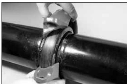
7. **MONTAGE DES SEGMENTS DE COLLIER :** mettez les segments de collier en place sur le joint. Vérifiez que les talons des segments s'engagent correctement dans les rainures des deux tubes/éléments à assembler.
