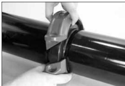
3. **MISE EN PLACE DES SEGMENTS :** utilisez la possibilité d'ouverture des segments pour mettre les segments en place sur le joint. Vérifiez que les talons des segments s'engagent complètement dans les rainures des extrémités des deux tubes.
