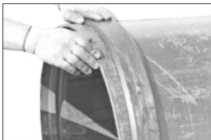
**3. MISE EN PLACE DU JOINT :** mettez le joint en place sur l'extrémité du tube ou sur le Vic-Ring AGS. Assurez-vous qu'il ne dépasse pas de l'extrémité du tube ou du Vic-Ring AGS.
