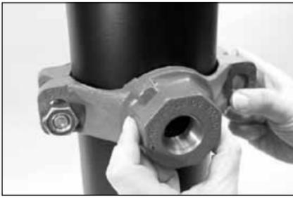
**3a.** Assurez-vous que la collerette de positionnement s'engage correctement dans le trou de sortie. Pour vérifier cet engagement, faites basculer le segment supérieur (de sortie) d'un côté à l'autre et retour dans le trou.
