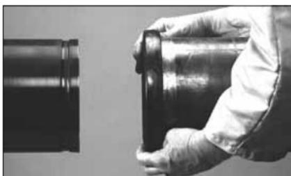
**3. INSTALLATION DU JOINT** : placez la plus grande ouverture du joint (marquée NPS) sur la plus grande extrémité du tube (côté NPS). Vérifiez que le joint ne dépasse pas de l'extrémité du tube.
