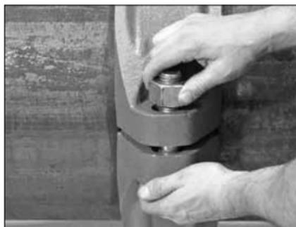
**6. MONTAGE DES SEGMENTS :** placez les segments sur le joint. Assurez-vous que les talons des segments s'engagent complètement dans la rainure de chaque extrémité de tube ou de Vic-Ring AGS. Soutenez les segments tout en préparant le montage des boulons et des écrous.
