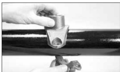
**3. MISE EN PLACE DU SEGMENT :** mettez le segment de piquage en place sur le tube en centrant la collerette de positionnement dans le trou. Vérifiez que le segment de sortie soit bien engagé en essayant de le faire aller et venir tout en appuyant dessus. S'il est correctement en place, il doit pouvoir bouger un peu, dans n'importe quelle direction.
