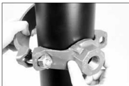
**3. MISE EN PLACE DES SEGMENTS :** tournez le segment inférieur du collier à environ 90° du segment supérieur (de sortie), comme illustré ci-dessus. Placez le segment supérieur (avec la sortie) sur le tube, en l'alignant vis-à-vis du trou de sortie dans le tube. Faites pivoter le segment inférieur pour le mettre en place autour du tube.
