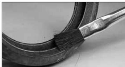
3. **LUBRIFICATION DU JOINT** : appliquez une fine couche de lubrifiant Victaulic ou base silicone sur les lèvres du joint et sur l'extérieur du joint. Il est normal que la surface du joint ait une couleur blanchâtre après qu'il ait été utilisé. **REMARQUE : LES SEGMENTS ET JOINTS DES COLLIERS 107H NE SONT PAS INTERCHANGEABLES AVEC LES SEGMENTS ET JOINTS DES COLLIERS 107.**
