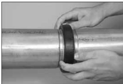
**4. ASSEMBLAGE DES EXTRÉMITÉS DE TUBES** : alignez les deux tubes face à face et rapprochez leurs extrémités. Glissez le joint en position et centrez-le entre les rainures de chaque extrémité des tubes. Assurez-vous qu'aucune partie du joint ne déborde dans la rainure d'une des extrémités des tubes.
