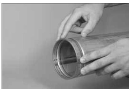
**1. CONTRÔLE DES EXTRÉMITÉS DE TUBES :** la surface extérieure du tube, entre la rainure et l'extrémité du tube, doit être lisse et ne pas présenter de cavités ou de saillies (telles que des cordons de soudure), ni de marques de molette, pour que le joint soit parfaitement étanche. Toute trace d'huile, de graisse, de peinture détachée, de saleté ou de particules de rainurage par enlèvement de métal doit être enlevée.
