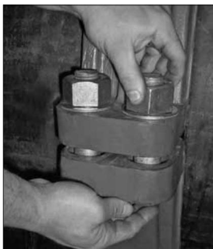
**6a. INSTALLATION DE RONDELLES PLATES/ D'ÉCROUS :** installez une rondelle plate (fournie avec le collier) sur l'extrémité de chaque boulon, puis vissez un écrou sur chaque boulon et serrez-les à la main. **REMARQUE :** veillez à ce que le collet ovale de chaque boulon soit bien en place dans le trou de boulon des segments.
