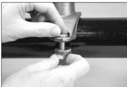
**4. INSTALLATION DU BOULON ET DE L'ÉCROU RESTANTS :** mettez en place le boulon restant dans le segment de piquage et dans le segment inférieur. Serrez un écrou à embase à la main sur le boulon. **REMARQUE :** veillez à ce que le collet ovale de chaque boulon soit bien en place dans le trou du patin.
