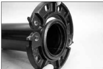
**4. MISE EN PLACE DE L'ADAPTATEUR DE BRIDE :** ouvrez au maximum l'adaptateur de bride articulé et mettez-le en place sur le joint. Assurez-vous que le talon de la bride s'engage correctement dans la rainure du tube.
