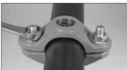
**5. SERRAGE DES ÉCROUS À EMBASE :** serrez les écrous à embase de manière égale et progressive jusqu'à environ 27,1 N•m/20 ft-lbs pour assurer une compression correcte du joint. **REMARQUE :** pour éviter un serrage excessif des écrous à embase, utilisez une clé d'une longueur inférieure ou égale à 200 mm/8 pouces. **NE serrez PAS** excessivement les écrous à embase.
