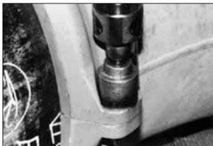
**4. SERRAGE DES ÉCROUS :** serrez tous les écrous de manière régulière en alternant les côtés jusqu'à ce que les surfaces métalliques des patins soient en contact. Veillez à ce que les talons des segments s'engagent complètement dans les rainures. **REMARQUE :** il est important de serrer les écrous de manière régulière pour éviter de pincer le joint.
