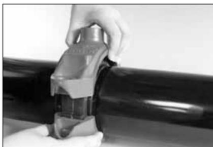
**6. MONTAGE DU SEGMENT SUPÉRIEUR :** mettez le segment supérieur en place sur le joint. Vérifiez que les talons des segments s'engagent complètement dans les rainures des extrémités des deux tubes. Inspectez l'ouverture de sortie afin de vous assurer que le col de sortie du joint est correctement positionné dans le segment.
