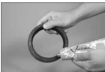
**2. CONTRÔLE ET LUBRIFICATION DU JOINT :** vérifiez que le joint convient pour l'utilisation envisagée. Appliquez une mince couche de lubrifiant Victaulic ou de lubrifiant au silicone sur les lèvres intérieures et à l'extérieur du joint.
