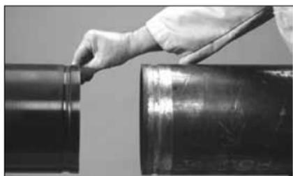
**1. CONTRÔLE DES EXTRÉMITÉS DE TUBES** : la surface extérieure des tubes, entre la rainure et l'extrémité du tube, doit être lisse et ne pas présenter de cavités ou de saillies (telles que des cordons de soudure), ni de marques de molette, pour assurer une parfaite étanchéité. Toute trace d'huile, de graisse, de peinture détachée, de saleté ou de particules de rainurage par enlèvement de métal doit être enlevée.
