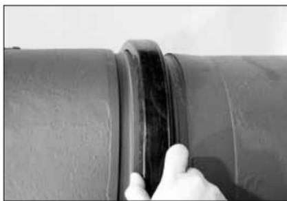
**4a. Si le joint monté à l'envers à l'étape 3a sur des colliers non AGS de diamètre supérieur** : roulez le joint en position et centrez-le entre les rainures de chaque extrémité des tubes. Assurez-vous qu'aucune partie du joint ne déborde dans la rainure d'une des extrémités des tubes.
